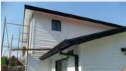
Sistema de revestimiento tinglado de acero con color y textura de madera. Tiene ventajas estéticas, por sus infinitos colores y terminaciones, al igual que ventajas en rendimiento al compararlo con otras soluciones disponibles en el mercado. Su propuesta de valor es la disminución hasta en un 50% en los tiempos de instalación, con mayor rendimiento y menos merma.
